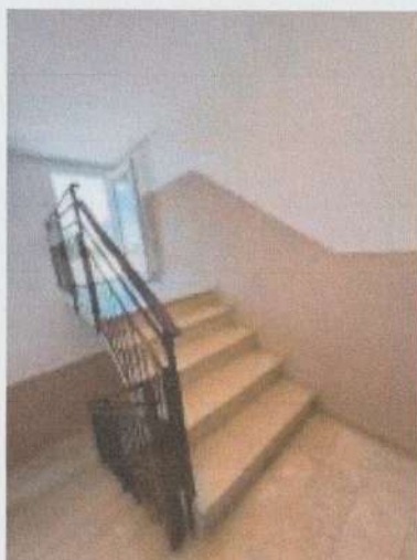
Vista dell' ultima rampa di scale ed accesso alla terrazza comune
