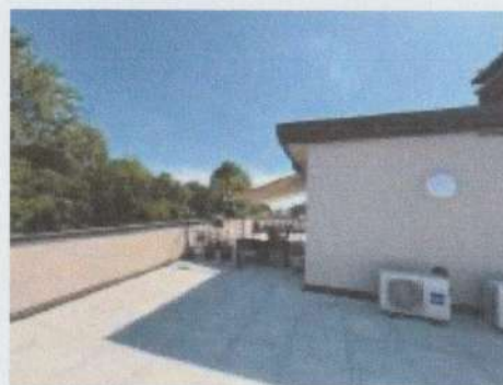
Confine di separazione tra terrazza comune/esclusiva
